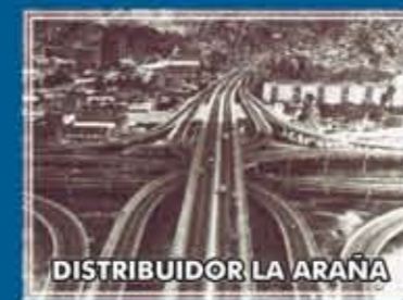
DISTRIBUIDOR LA ARANA
