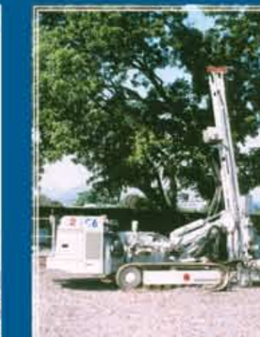
Muros Proyectados Anclados Espesor: 0.05 - 0.30 mts. Anclajes: Carga 10 - 150 ton.
