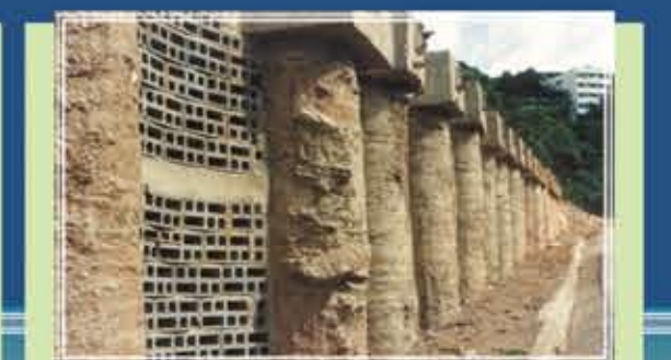
MURO BERLIN PILAS PERFORADAS
