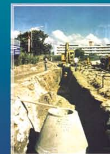
Rebajas de Nivel Freático Well Points Pozos Profundos
