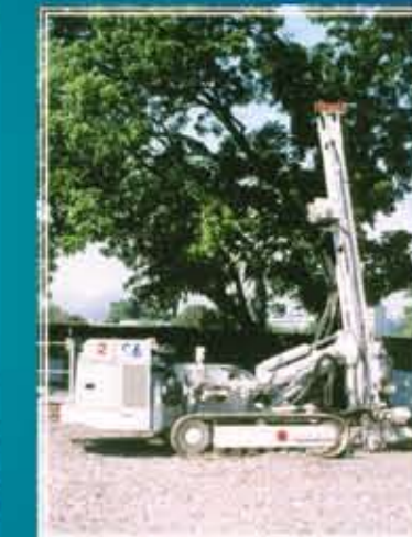
Muros Projectados Anclados Espesor: 0.05 - 0.30 mts. Anclajes: Carga 10 - 150 ton.
