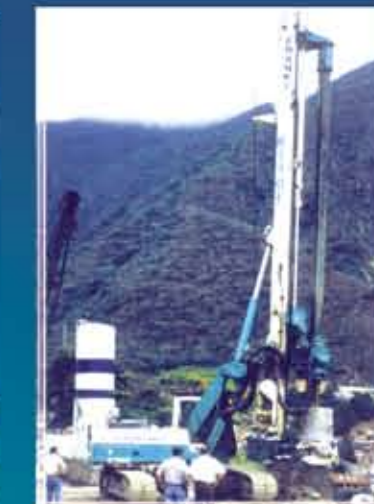
Pilas Circulares Diám.: 0.45 - 2.00 mts. Prof. máx.: 40 - 50 mts.
